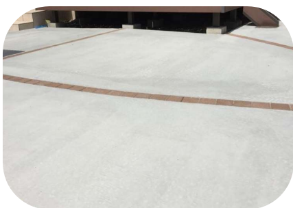
土間コンクリート
